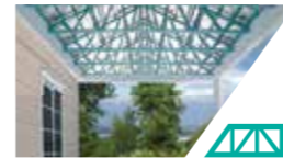
Hệ kèo mái hiện
