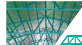
Hệ kèo mái tôn
